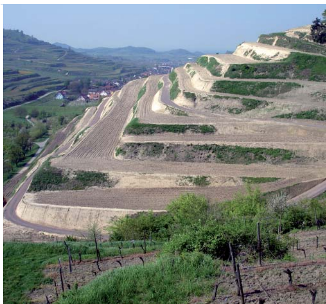
Während der Bauphase
