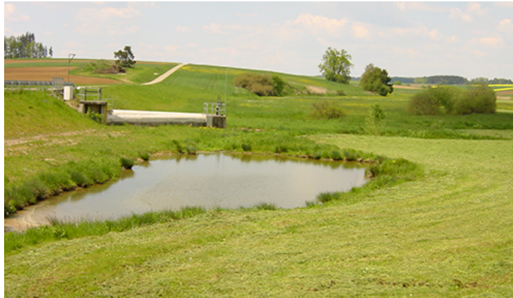
Umsetzung von Hochwasserschutzmaßnahmen
